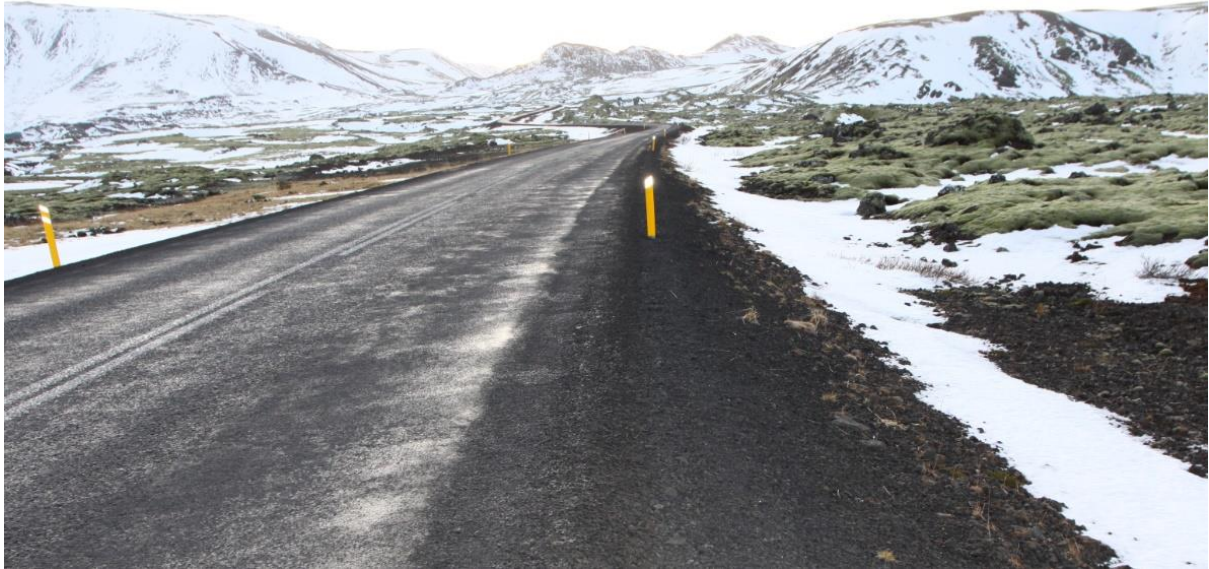
Mynd 34. Bláfjallavegur í Vífilsfellshrauni, horft til suðurs, hér er hæð vegarins yfir aðliggjandi land hvað minnst og hraunið hægra megin við veginn er óhreyft.
