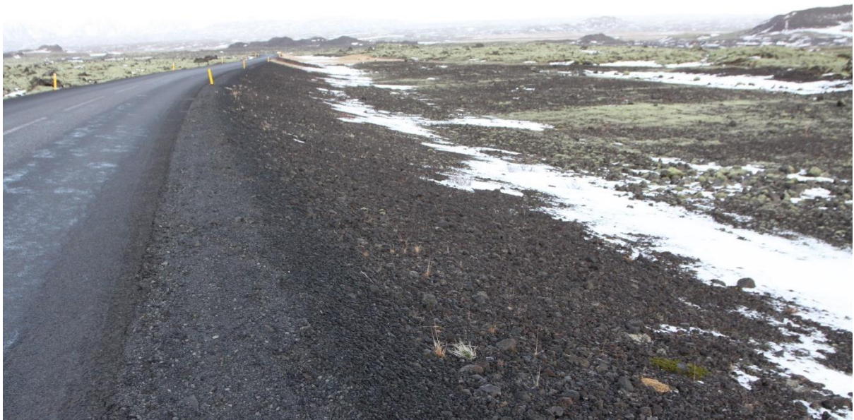
Mynd 35. Bláfjallavegur í Vífilsfellshrauni, horft til norðurs, ágæt hæð yfir landi, hliðarsvæði útjafnað, hér hentar vegflái vel til strenglagningar.
