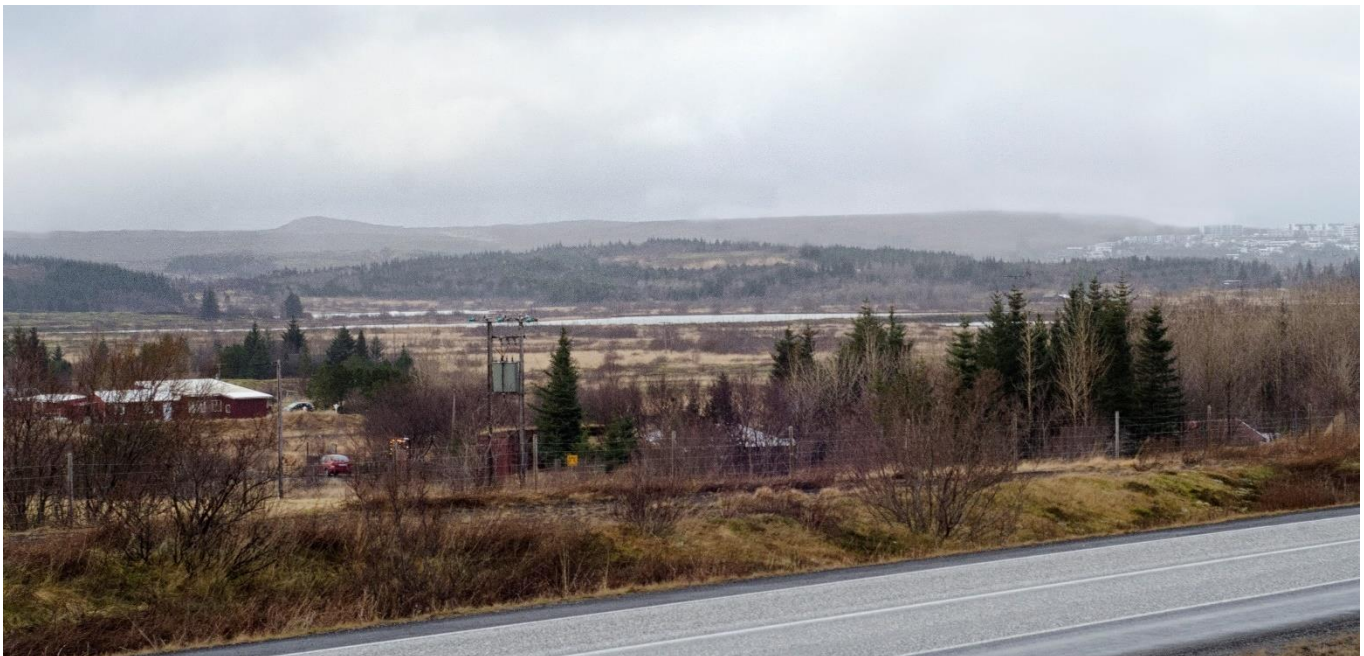
Mynd 7. Ásýnd frá Suðurlandsvegi eftir að búið er að fjarlægja Hamraneslínur 1 og 2, horft til suðvesturs.
